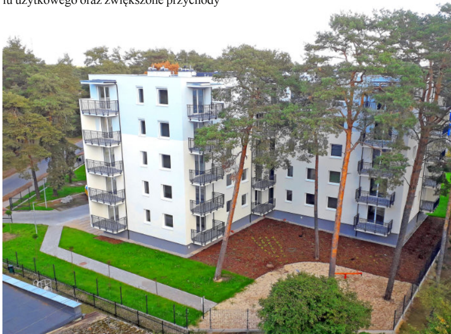
Widok nowo oddanego budynku mieszkalnego w Trzcińcu, przy ulicy Gminnej 17a.
